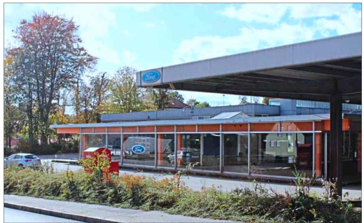
Nur noch das Ford-Zeichen glänzt: Das brach liegende Gebäude des ehemaligen Autohauses Bachhuber. Auf dem verwahrlosten Gelände sollen 42 neue Wohneinheiten entstehen. – Foto: Mühling
