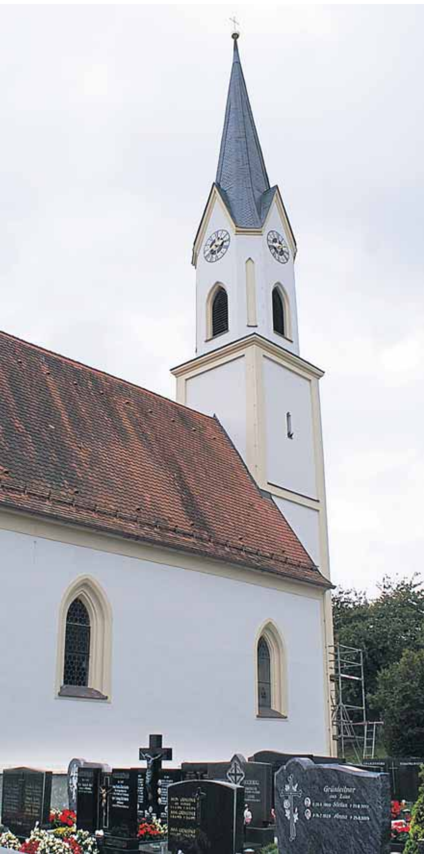
Aufatmen in der Pfarrei Kirn: Nach Jahren der Renovierungsphase erstrahlt die Pfarrkirche St. Ulrich in Kirn innen und außen wieder in neuem Glanz.
