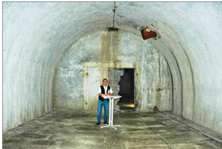
Das Kellergewölbe ist derzeit verwaist.
