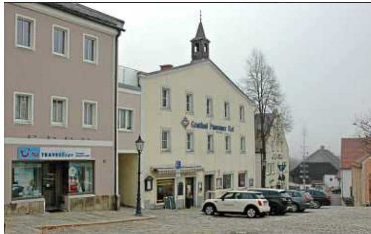
Eines der stadtbildprägenden Gebäude: das Gasthaus Passauer Hof in der Freyunger Innenstadt.
